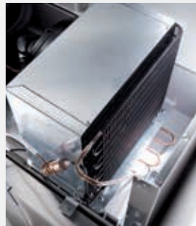
Condensatore auto-pulente
